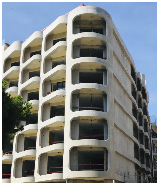
Photo en cours de chantier ▲
