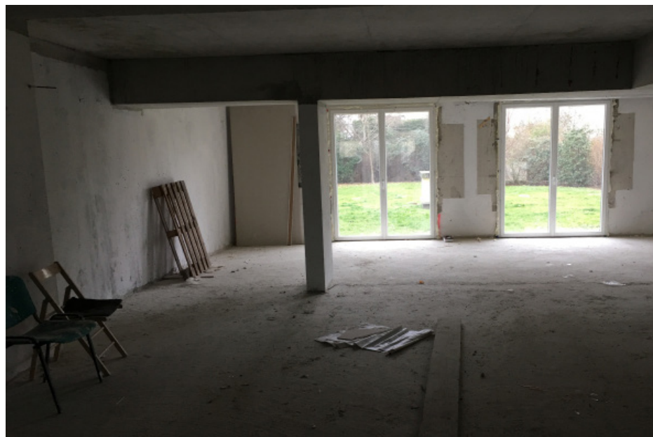
Photo chantier- Sans échelle ▲
