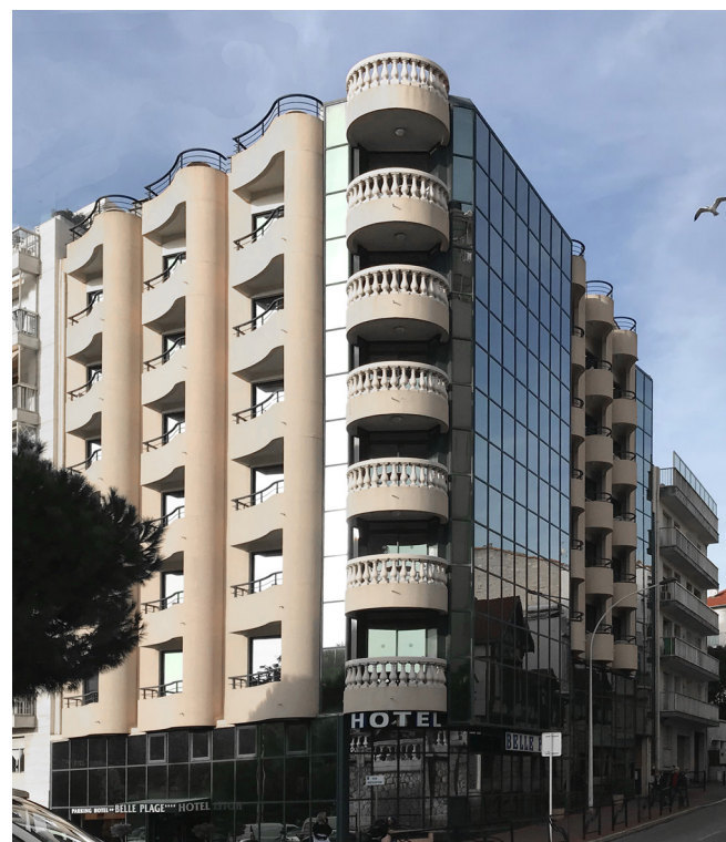
Photo avant travaux ▲
