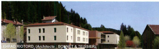
EHPAD RIOTORD - (Architecte : BONNET & TEISSIER)
