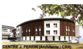
CENTRE J. PERRIN (Architecte : CRR)
