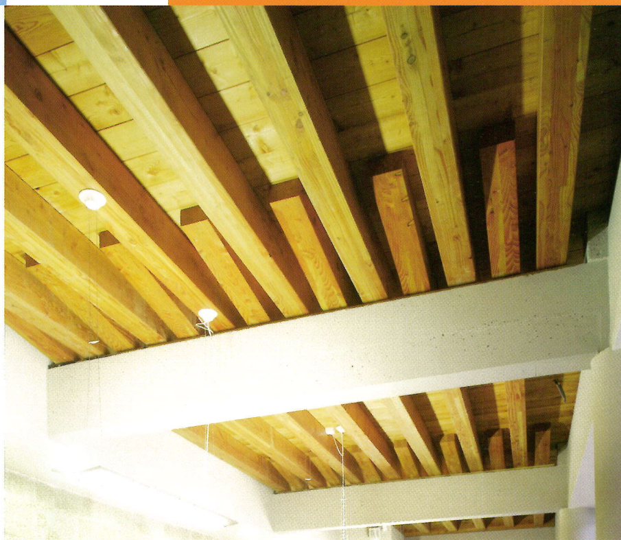
Une large place est faite au bois. Ici au plafond d'une grande salle de réunion.
