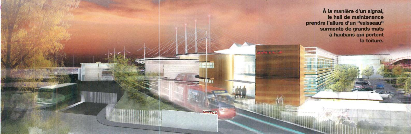
À la manière d'un signal, le hall de maintenance prendra l'allure d'un "vaisseau" surmonté de grands mats à haubans qui portent la toiture.
