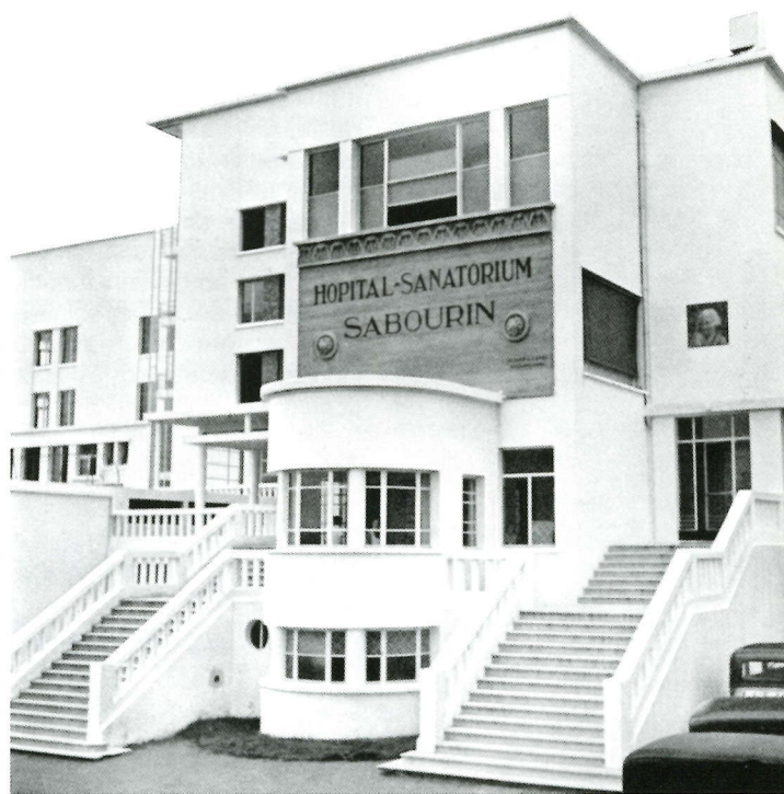
Au Nord, l'entrée principale très saillante avec la loge circulaire du concierge encadrée par deux escaliers. Document de 1935.
