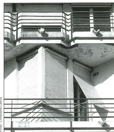
Les chambres, orientées à 45°, donnent un effet en « dent de scie », permettant un ensoleillement maximum.
