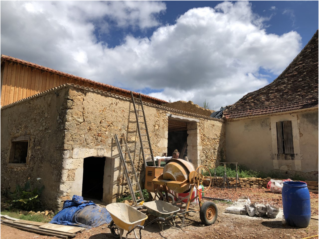
Talochage de murs avec enduits en terre
