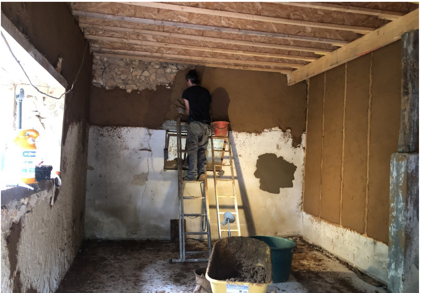
Talochage de murs avec enduits en terre
