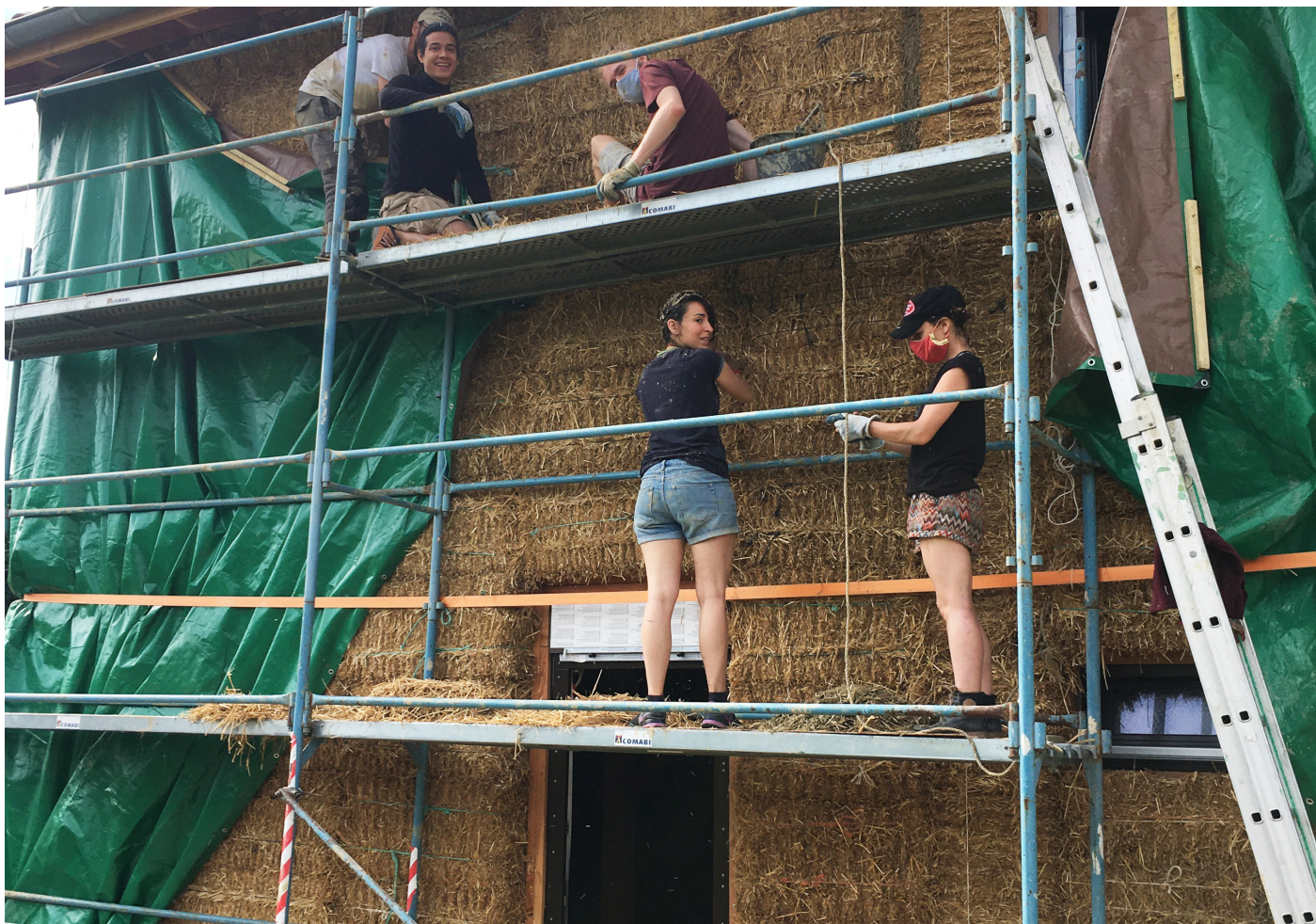
Remplissage entre les bottes de paille avec du torchis
