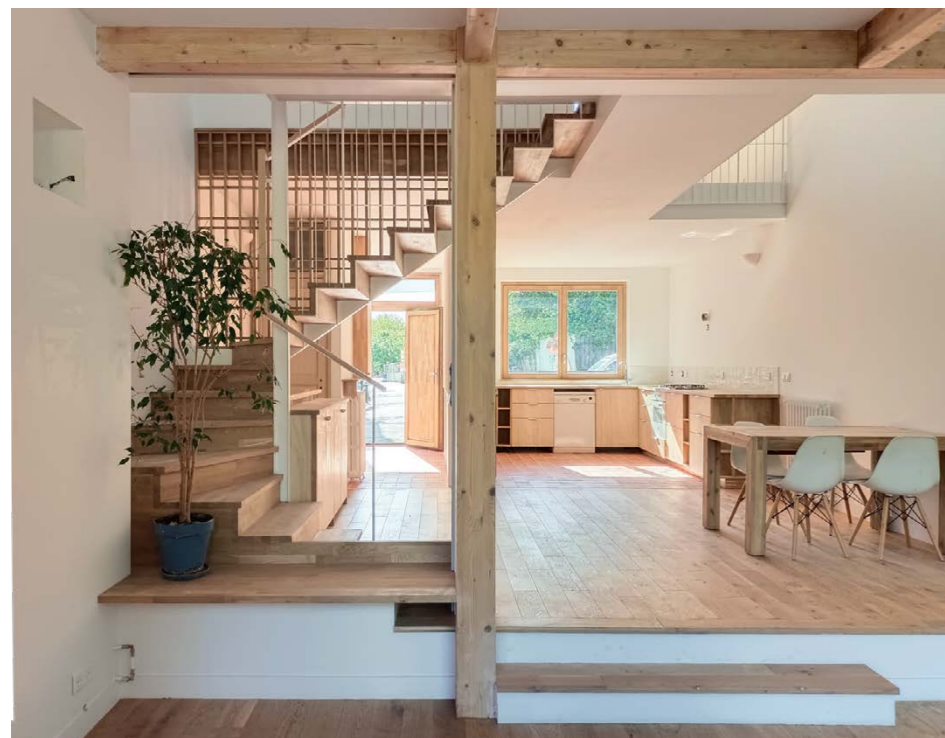
VUE DE L'ESCALIER - Limon suspendu / Composition autour des structures
