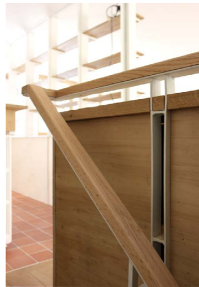
DÉTAIL - Main courante et mobilier, escalier vers la cave
