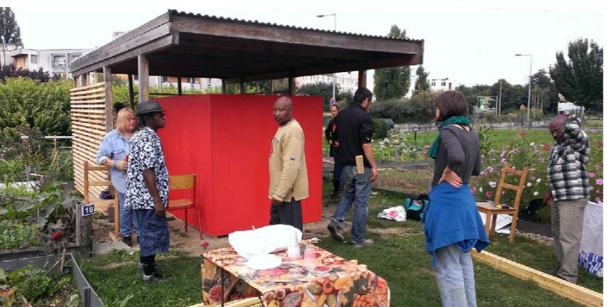
CONSTRUCTION COLLECTIVE D'ABRI POUR LES JARDINS PARTAGÉS, SEVRAN
