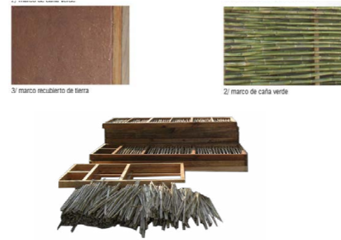
La technique du "bahareque" : réinvestir les modes constructifs vernaculaires
