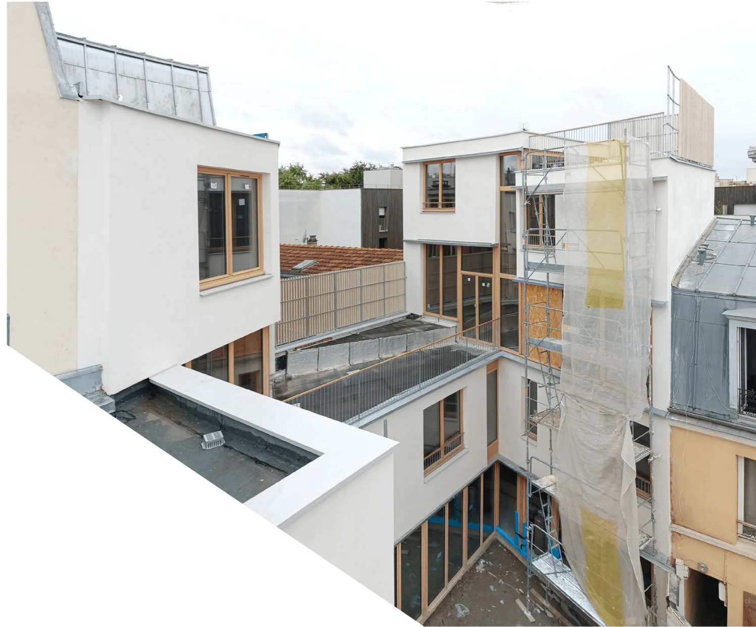
PHOTO DE CHANTIER - Vue cour nord-ouest
