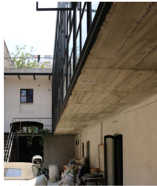
SOUS-FACE DU CORRIDOR SUSPENDU - Libération du sol du patio.
