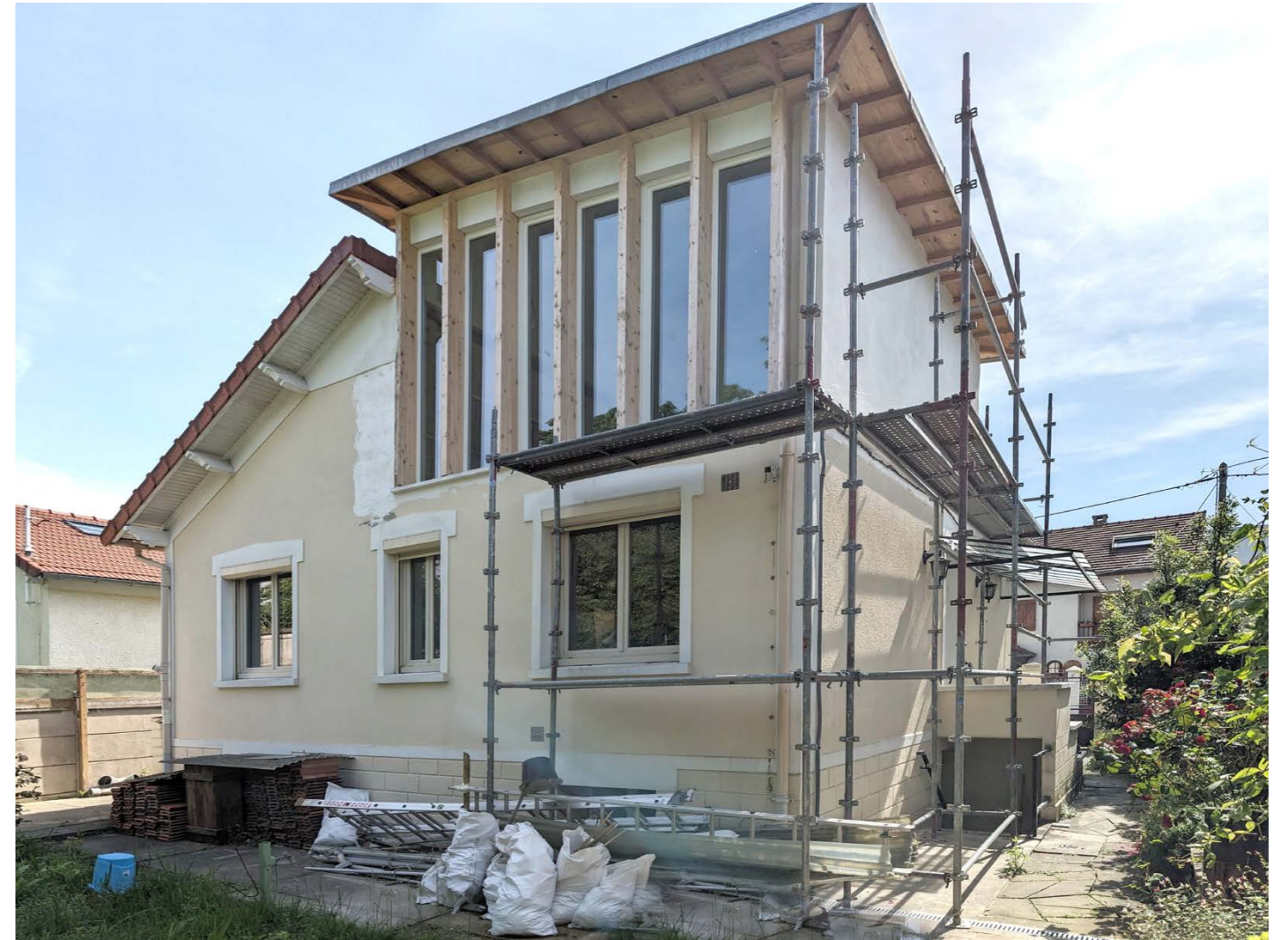
PHOTO DE CHANTIER - Vue Ouest
