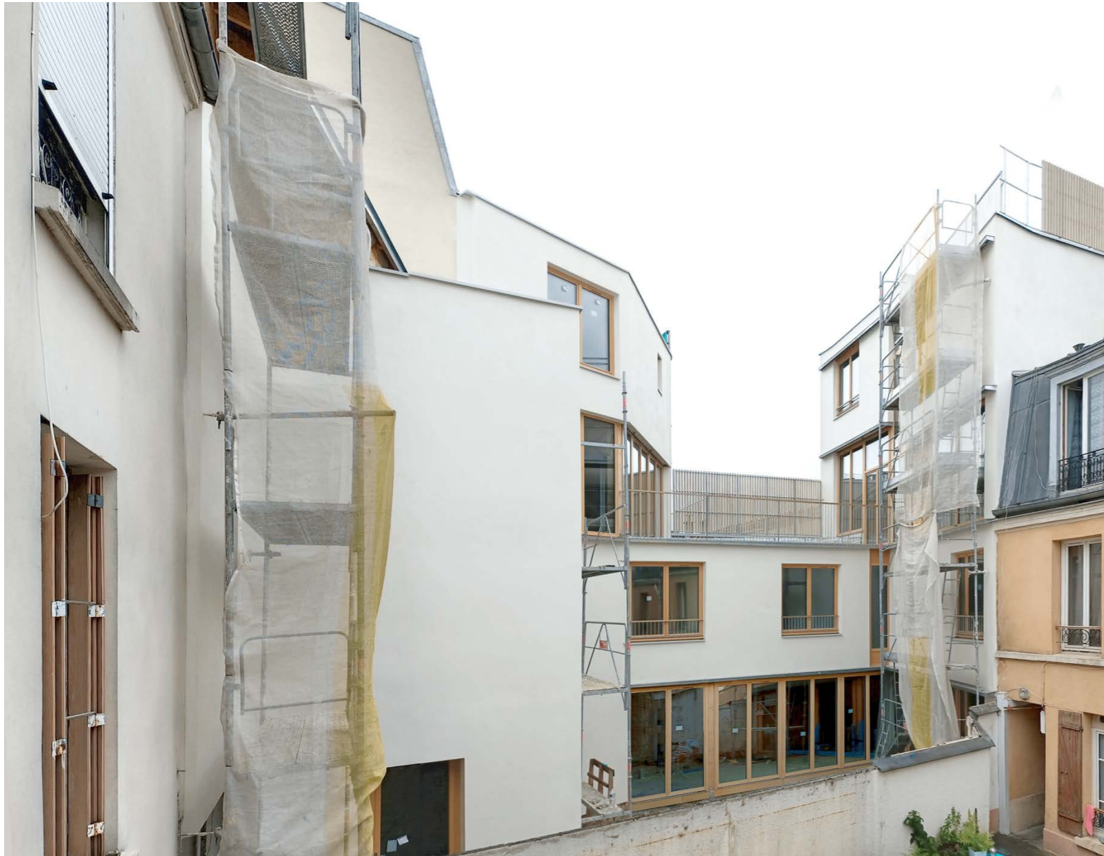
PHOTO DE CHANTIER - Vue nord-ouest
