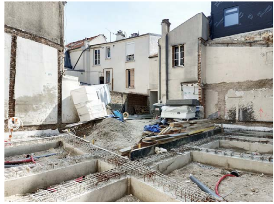
CHANTIER - Fondations mai 2023
