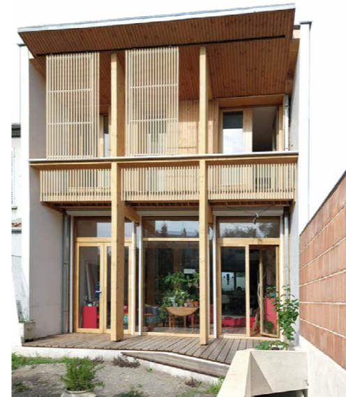
FAÇADE JARDIN - En cours de construction
