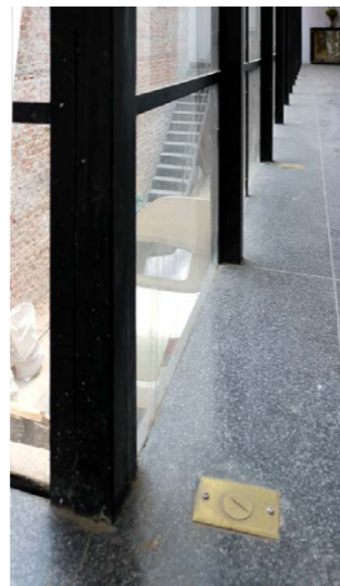
DÉTAIL - Intégration des suspentes à la dalle.
