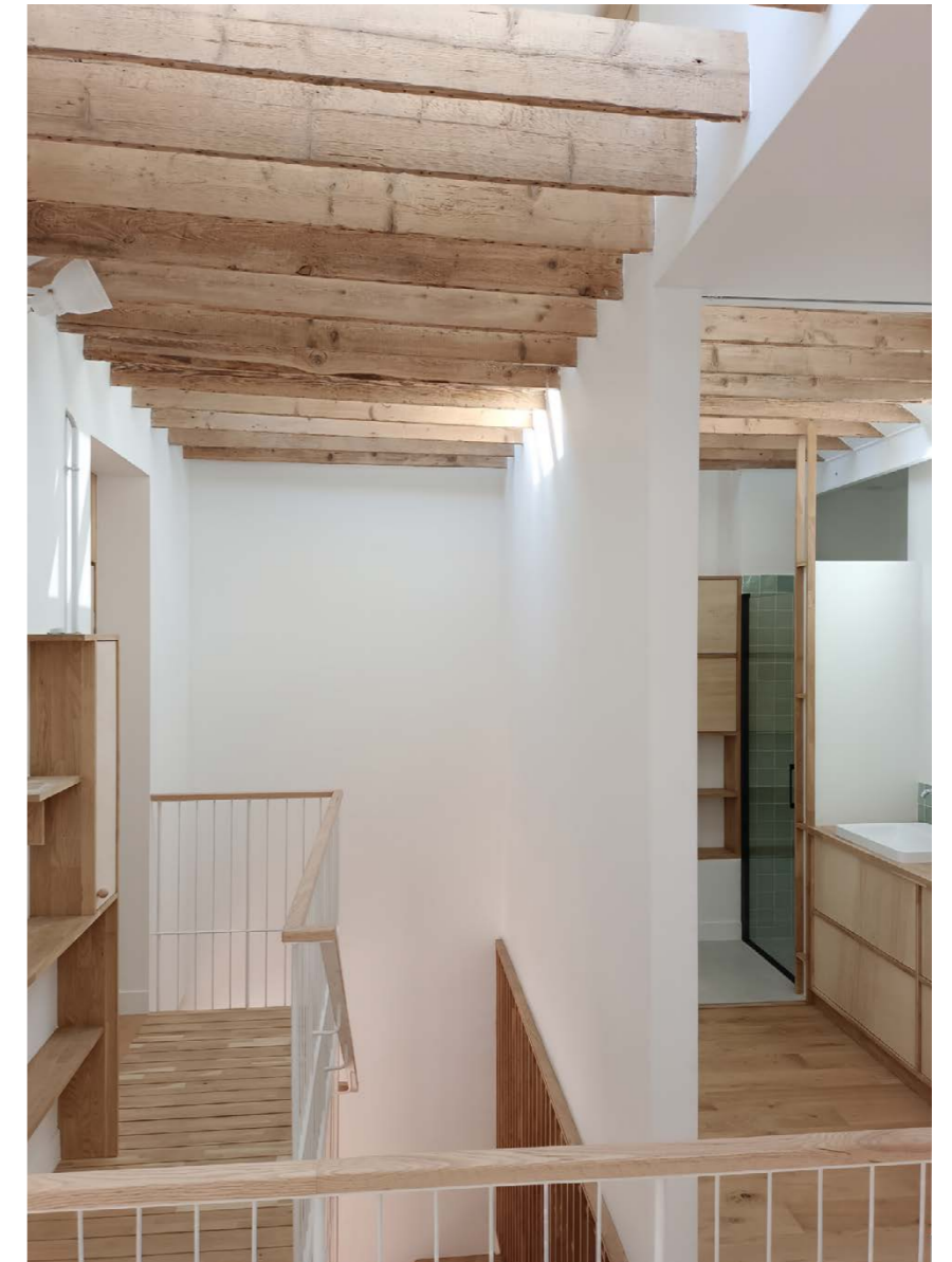
PALIER DU R+1 - Structure du plancher du grenier découverte faisant filtre zénithal.
