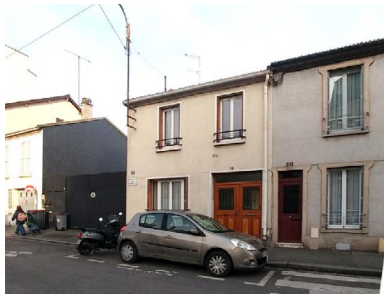
FAÇADE RUE BARBÈS, EXISTANT - Maison ouvrière
