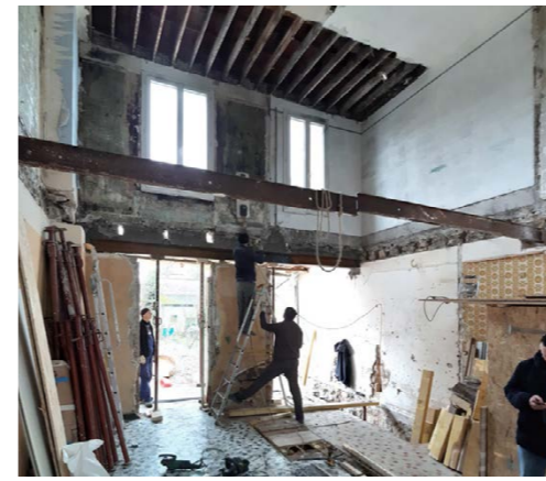
CHANTIER - Démolition du plancher existant, mise en place de la poutre maîtresse.
