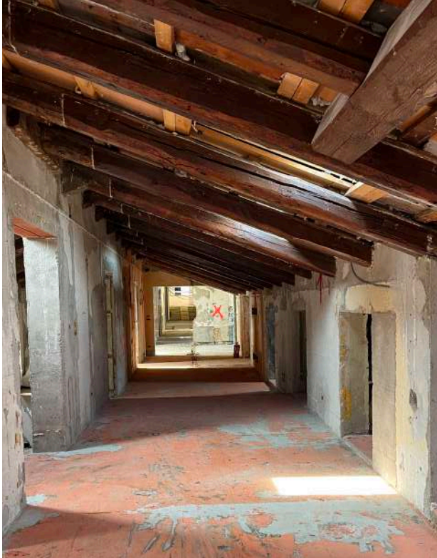
Photos en cours de chantier
