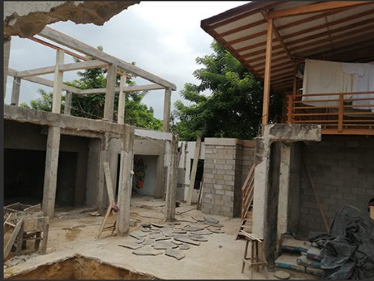
PHOTO CHANTIER Réhabilitation & extention du batiment existant
