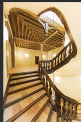
Restauration d'un escalier classé
