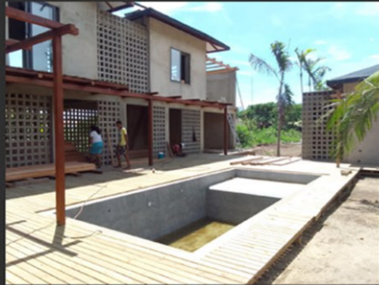
MISE EN PLACE DU DECK
