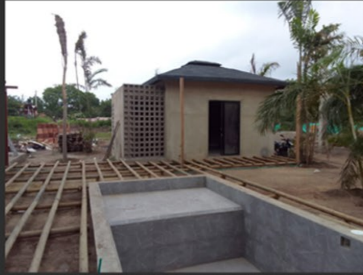
MISE EN PLACE DU SOLIVAGE POUR LE DECK BOIS
