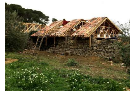
Jour de rendu final H-1, Décembre Tuiles posées, nous procédons aux dernières vérifications avant la présentation devant les habitants de Fabrègues.
