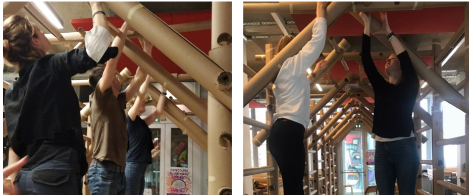
MISE EN PLACE EN COURS ET TESTS DE LA STRUCTURE
