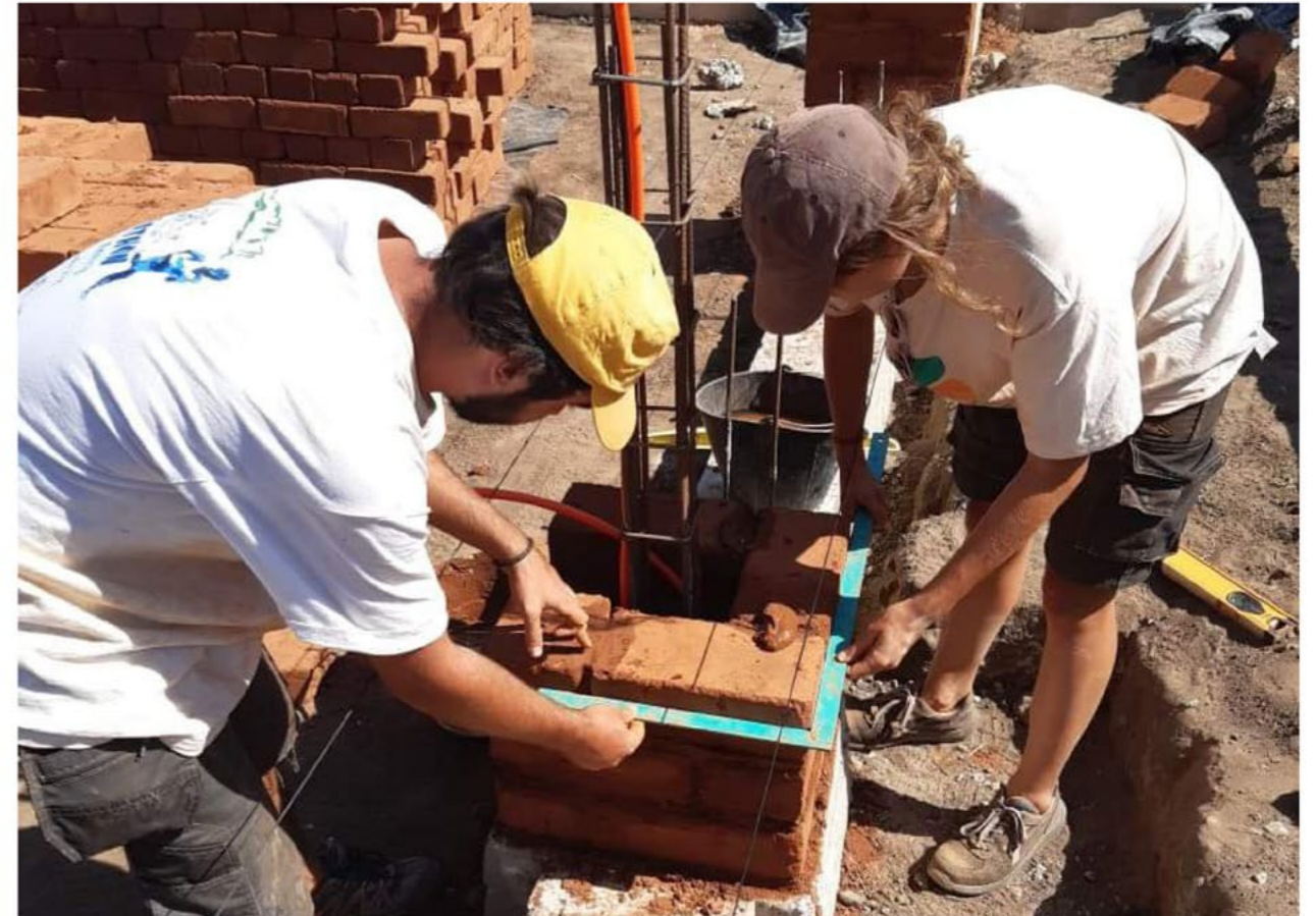
Montage des poteaux mixte BTC / Béton armé
