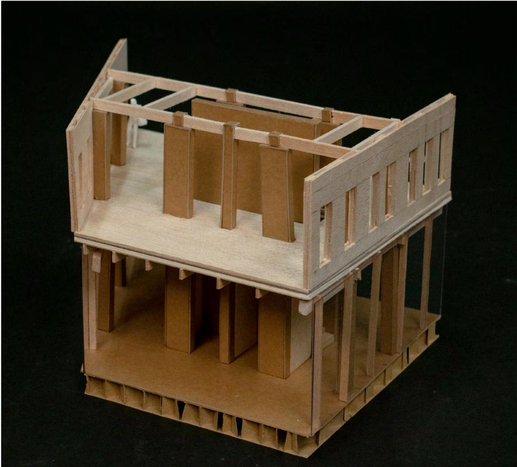
Relation entre le noyau fonctionnel en béton de terre et le premier niveau
