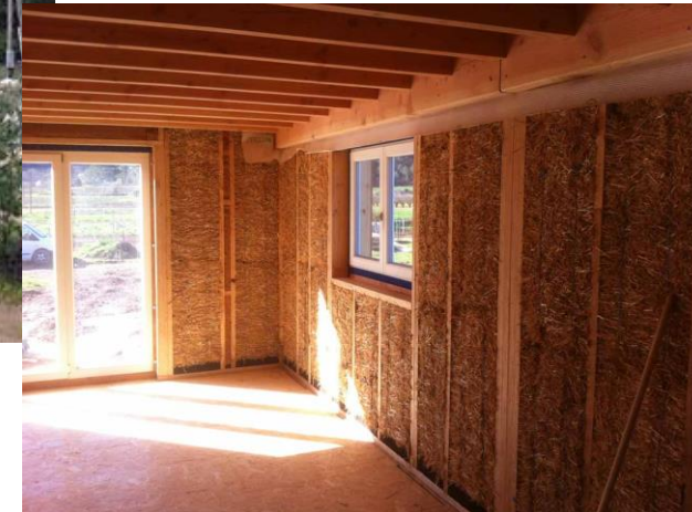
Isolation des murs en botte de paille en caisson. Solivage plancher en bois massif.
