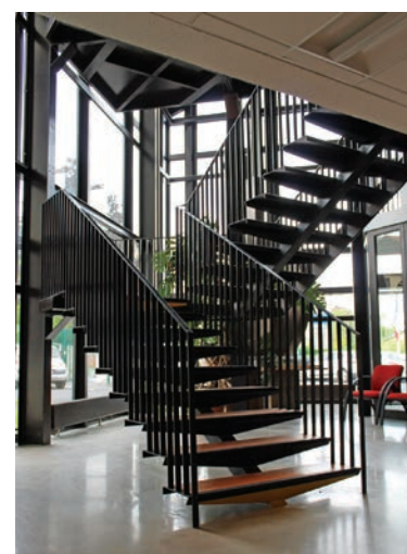
L'escalier métallique en échelle-de-perroquet du hall d'entrée principal.
