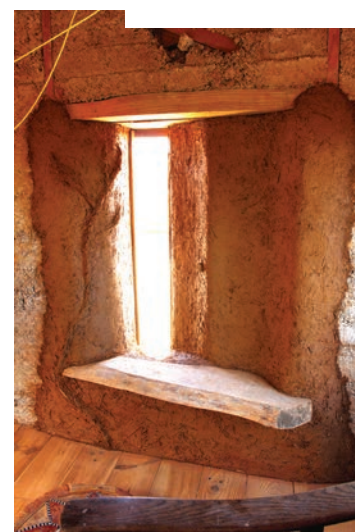
Création d'une fenêtre de type meurtrière
