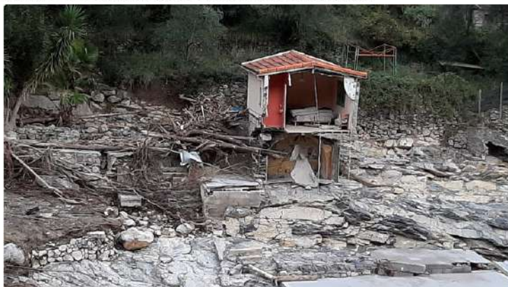
Une partie de cette maison située dans le hameau de Piene basse (Breil-sur-Roya, Alpes-Maritimes) a été emportée par la Roya lors du passage de la tempête Alex le 2 octobre 2020. ● Loïc Blacha/FTV
