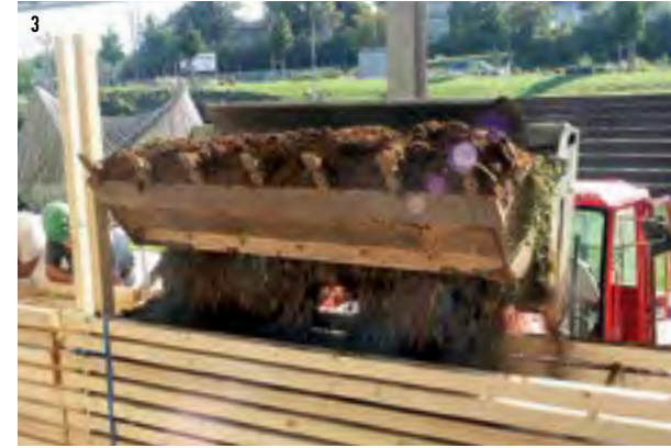
1 Prototype bois sanglé réalisé en 2006 aux Grands Ateliers. 2 & 3 Prototype en bois sanglé réalisé avec les étudiants du DSA-Terre en 2007.
