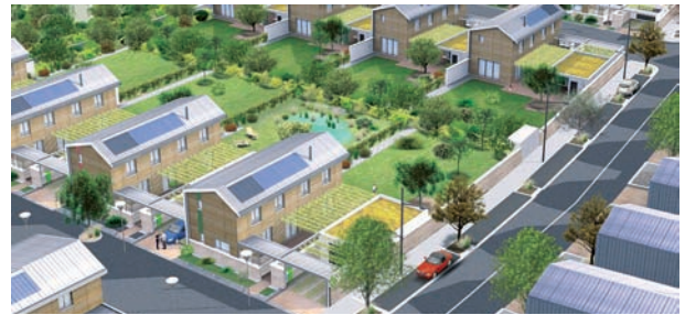
Vue aérienne d'une partie des maisons passives, Arch. Atelier Thierry Roche & Associés, livraison fin 2008
