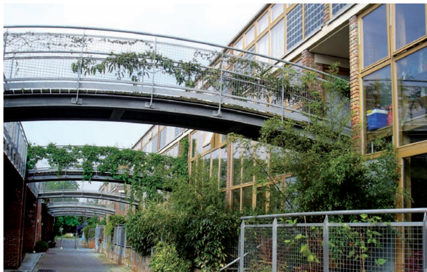
Passerelle d'accès aux jardins privés, BedZed, Arch. Bill Dunster © cnoa
