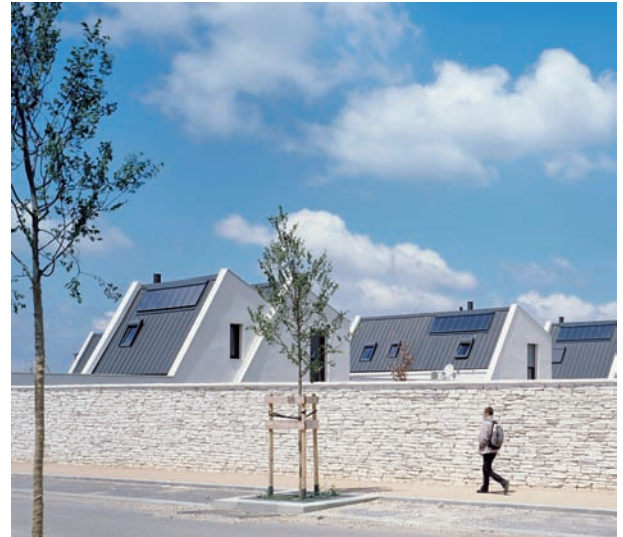
Capteurs solaires sur les maisons de ville, ZAC des Hauts de Feuilly, Arch. Agence Tekhnè, 2006 © Tekhnè
