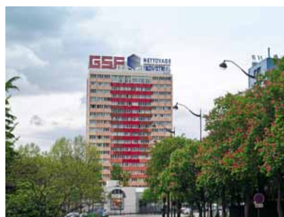
La tour avant réhabilitation. Des panneaux de couleur protègent l'isolant thermique installé en 1992.
