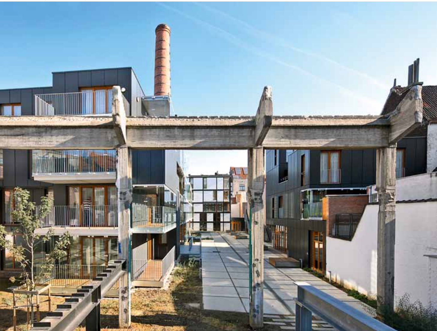
Les architectes ont conservé une structure béton de l'ancienne savonnerie. Découpée de façon sculpturale, elle sert de support à des jeux d'enfants
