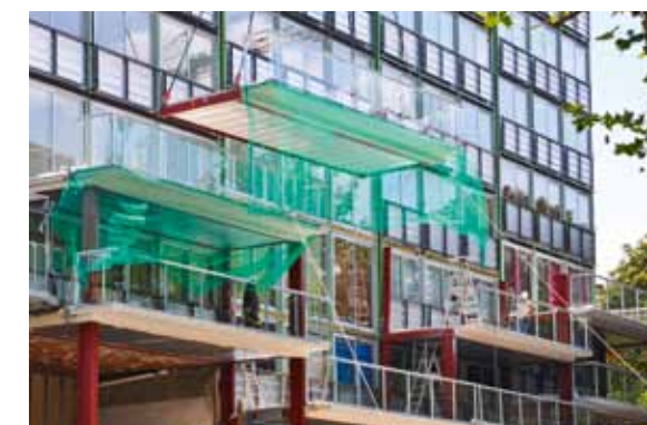
Mise en place des plateformes contenant les balcons et les jardins d'hiver. La façade qui apparaît en arrière plan est celle du bâtiment à l'origine.
