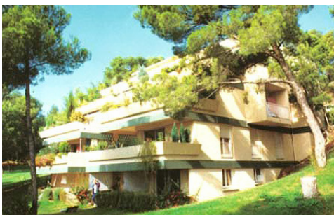
Maison sous les Pins, Villeneuve les Avignon
