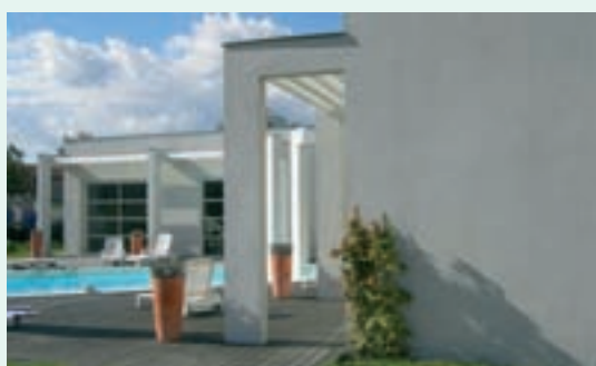
La Martière, agence Arcature et agence Chassary / Lebaron, © architectes
