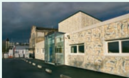
Maison du bois, PACA, Atelier d'Architecture Jérôme Voutier, © Jérôme Voutier
