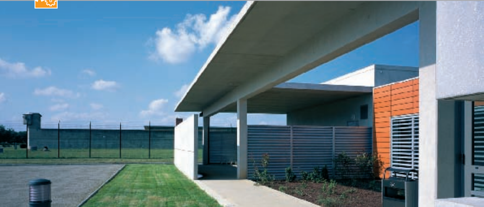
Structure d'accueil de l'équipe régionale d'intervention et de sécurité à Muret, 2006, APC Architectes Arch., © Arnaud Saint-Germès
