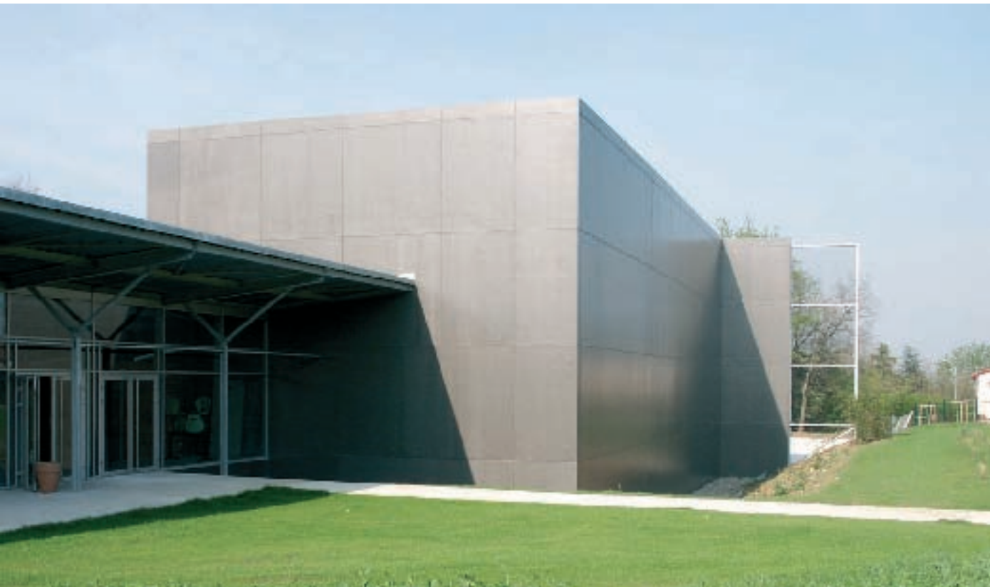
Complexe de jeux de raquettes à Blagnac, 2007, Jean-marie Bardin et Marc Julla Arch., © architectes
